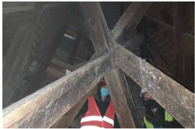
Toronszerkezet alsó része az azonos csomópontban találkozó dőltszékoszlopokkal
