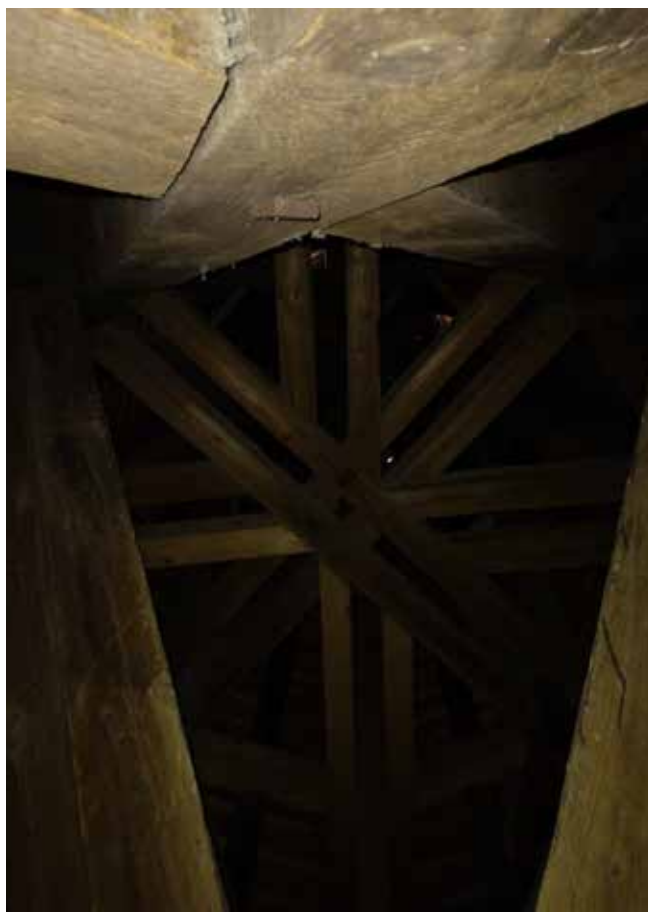
Ilyen fogópárok fogják közre a császároszlopot. A képen az üresen maradt szerkezet látható, az andráskereszt a mankókat merevíti.
